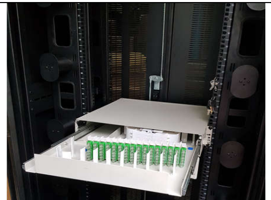
H4 – Gắn Module lên Tủ Rack hoặc Khung Rack 19’’ hờ
