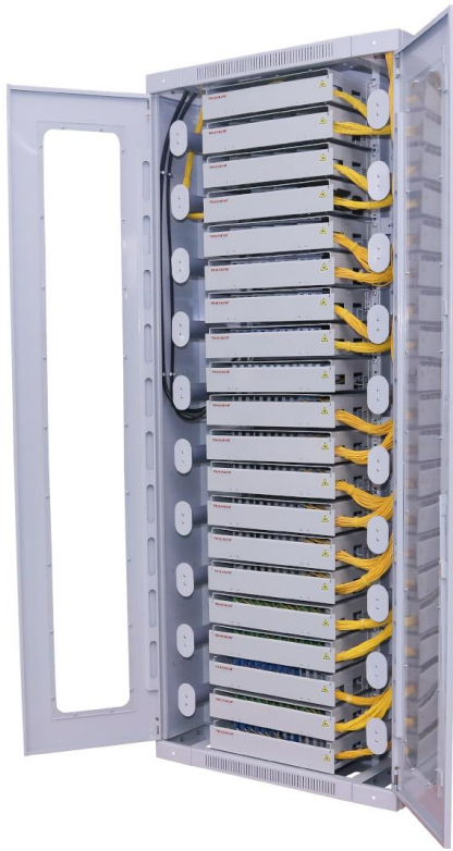
Hoàn thiện đấu nối 20 ODF 96FO
