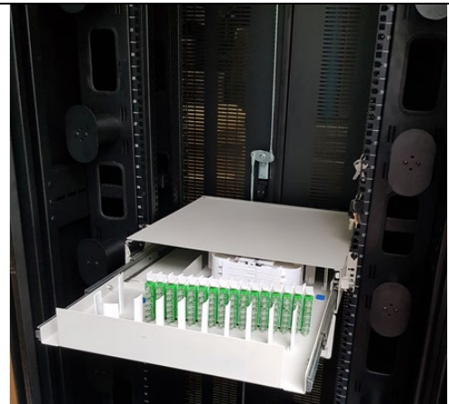
H4 – Gắn Module lên Tủ Rack hoặc Khung Rack 19’’ hờ
