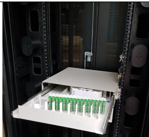
H2- Adapter và khay hàn bố trí bên trong Module. Dạng trượt
