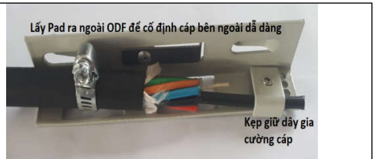
H2 - Cố định cáp vào Pad bên ngoài. Sau đó cài vào thân trong sau Module. Có trường hợp cài phía ngoài sau module khi cáp không đi được vào bên cạnh Module.
