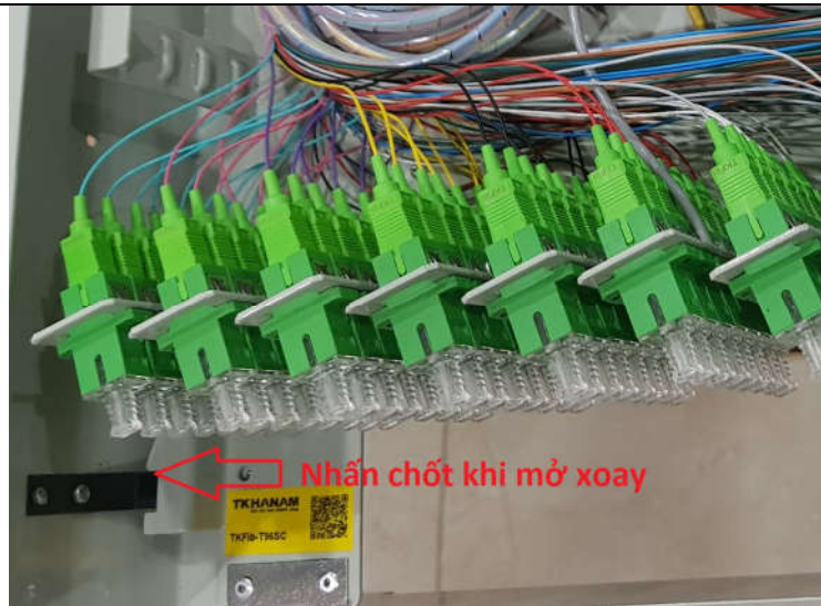
H.9 Khi mở Module luôn nhấn chốt lá đàn hồi.
