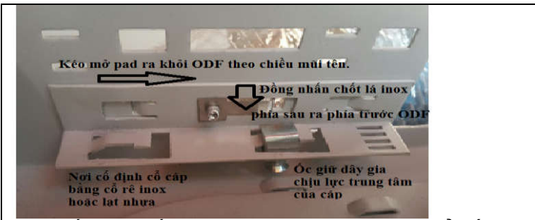
H1 - Lấy Pad cố định cáp vào ra khỏi ODF. Để cố định cáp vào bên ngoài
