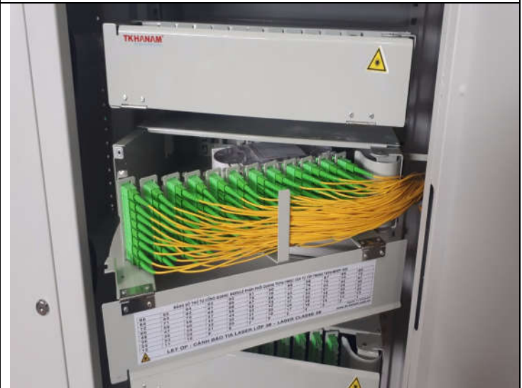
H.10 Module gắn lên Tủ tập trung 23" và Tủ Rack 19" các loại
