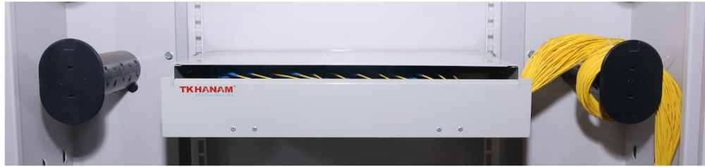
Lắp đặt trên tủ tập trung TKFib-WODF-19201L1RS
