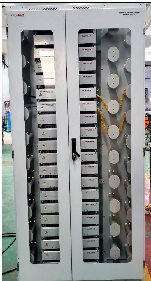
Hoàn thành sau khi hàn nối và đầu nhảy
