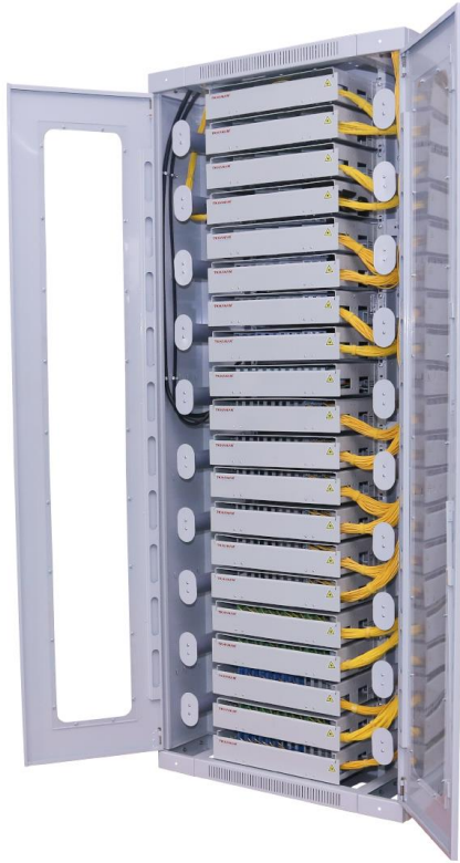
Hoàn thiện đấu nối 20 ODF 96FO
